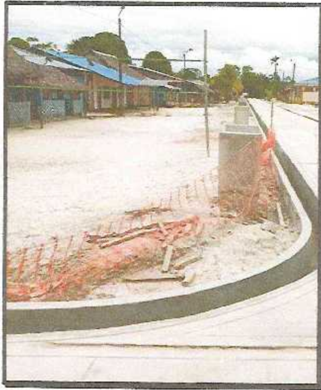
TOMA 5: VISTA DE LOS TRABAJOS DE CONCRETO F'C=175 KG/CM2 EN CUNETAS RECTANGULARES
