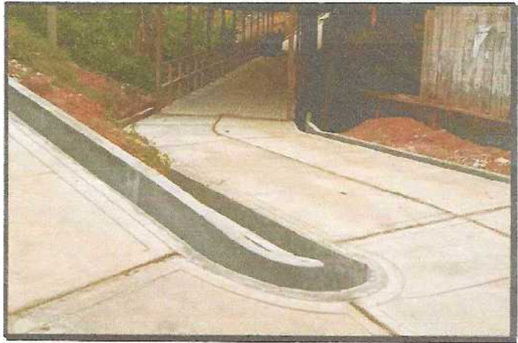
TOMA 7: VISTA DE LOS TRABAJOS DE TARRAJEO CON IMPERMEABILIZANTES EN CUNETAS EN LOS DIFERENTES TRAMOS.
