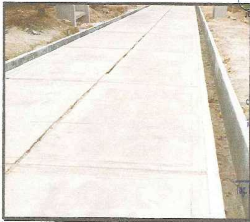
TOMA 2: VISTA DE LOS TRABAJOS DE VACEO DE VEREDA CONCRETO, ASIMISMO SE PUEDE OBSERVAR LOS BRUÑADOS EN VEREDAS.
