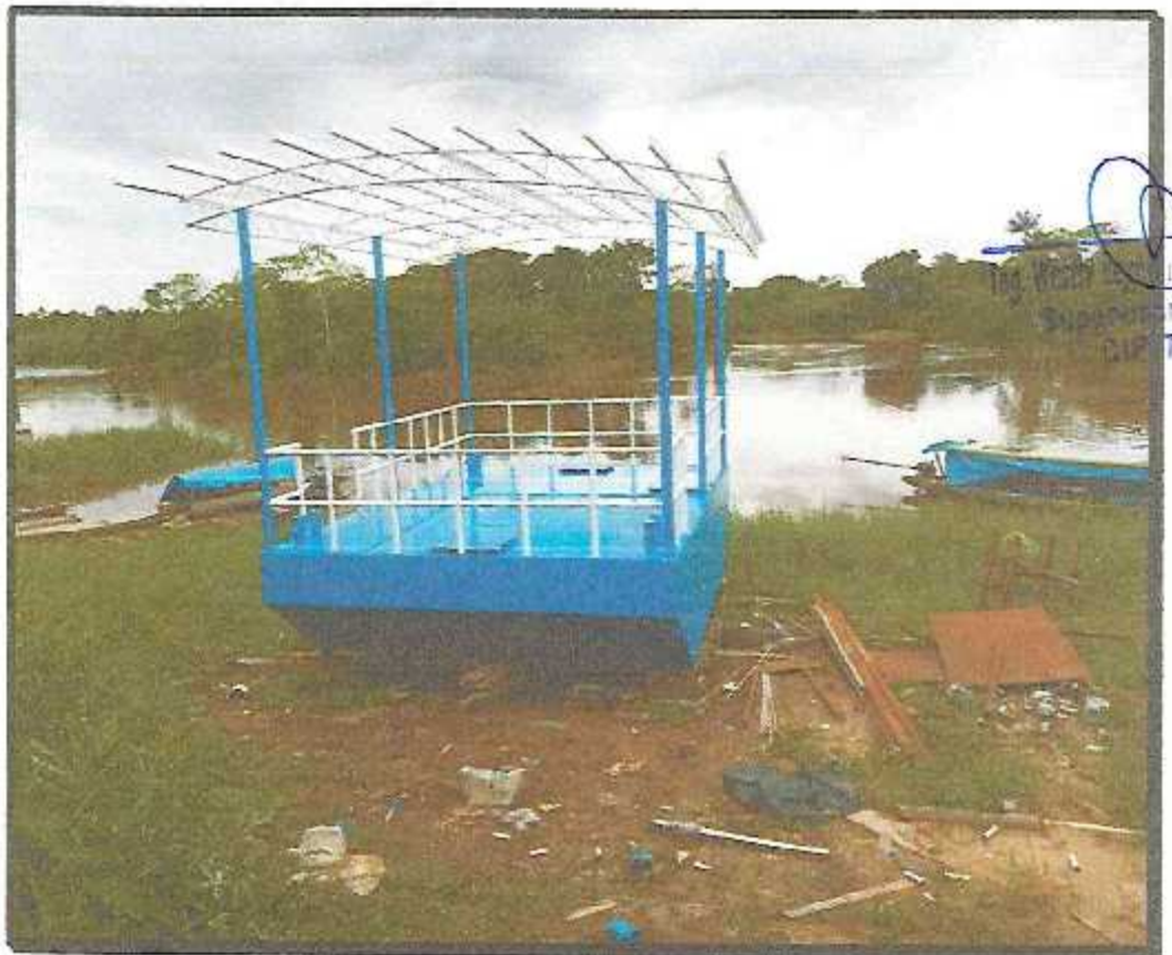
TOMA 10: VISTA PANORAMICA DE LA HABILITACION METALICA PARA LA CONSTRUCCION DEL PONTON METALICO
