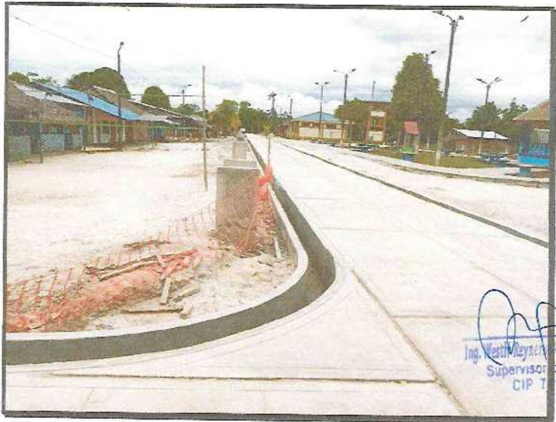
TOMA 4: VISTA DE LOS TRABAJOS DE CONCRETO F'C=175 KG/CM2 EN MARTILLO
