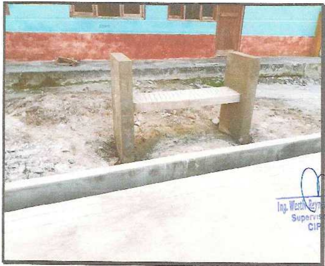
TOMA 8: VISTA DE LOS TRABAJOS DE CONCRETO F'c=175 KG/CM2 EN BANCAS.
