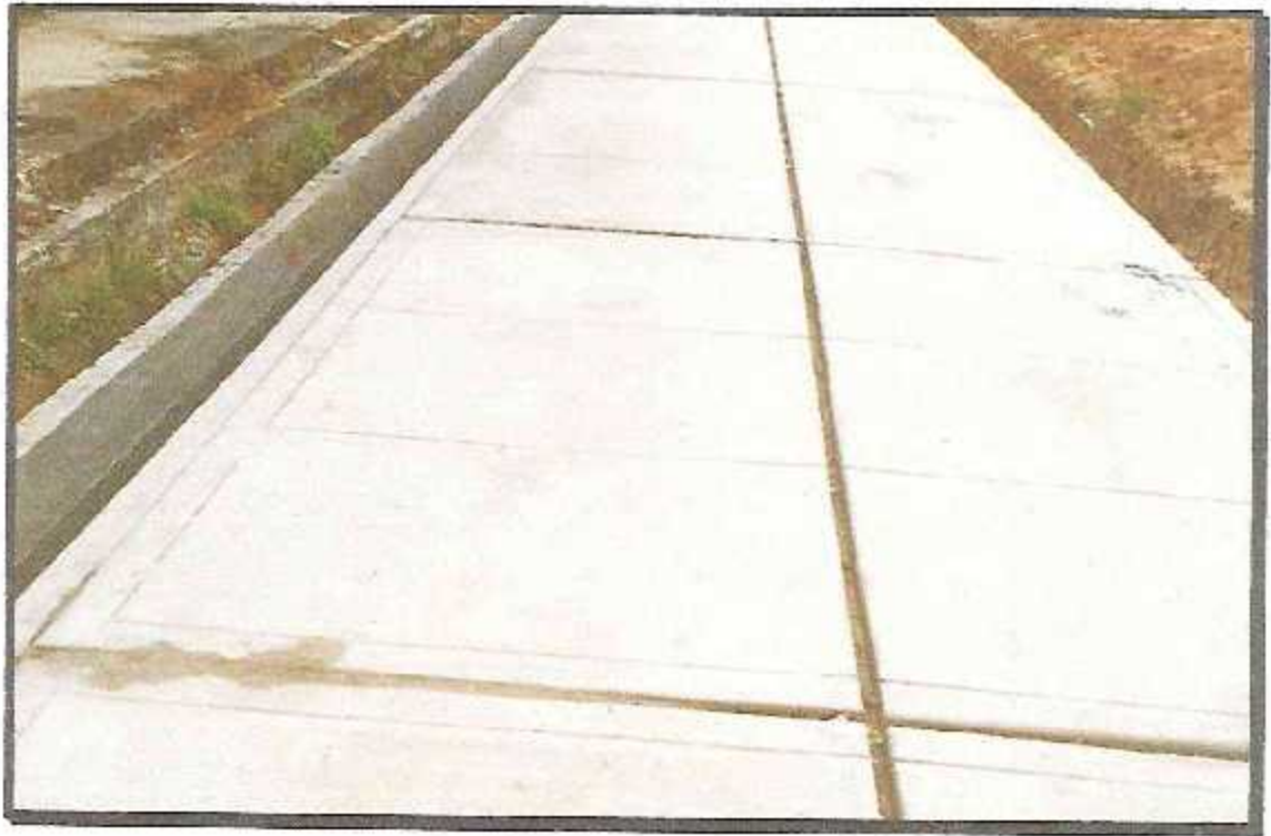
TOMA 3: VISTA DE LOS TRABAJOS DE JUNTAS DE DILTACION EN VEREDAS.
